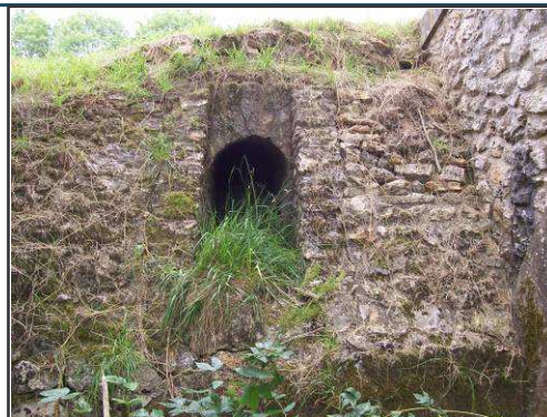
Photo 7 : Aqueduc de la Dhuis
